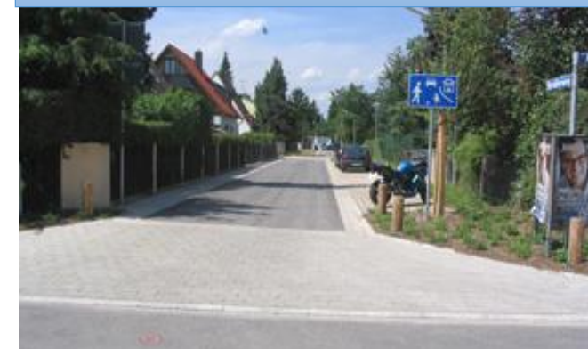
Gleichberechtigung auf Anliegerstraßen durch Aufheben der Trennung in Fahrbahn/Gehsteig, mit entsprechender Temporeduktion & rechtl. Sicherung (Foto: Büro Färber);
