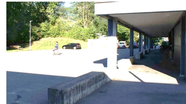
Informeller Treffpunkt beim Eingangsbereich M2: überdachte Bänke, kaum einsehbar; Und: sichere Verbindung abseits der Treietstraße
