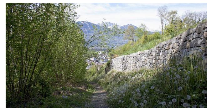
Sanierungsprojekt Trockenmauern Gemeinde Bludesch; (Foto: Gemeinde Bludesch)
